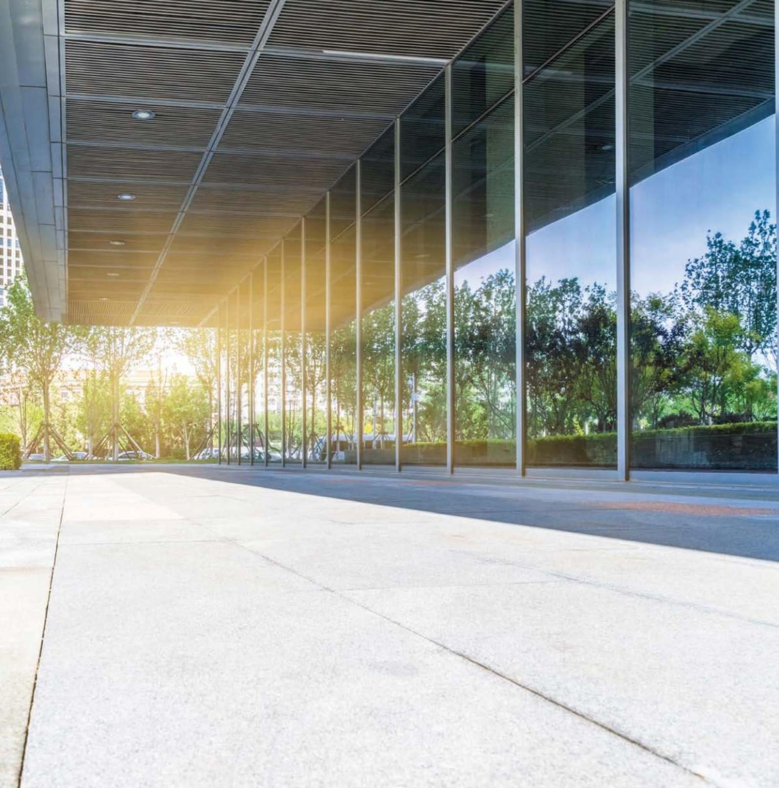
El sistema semiestructural **ECW-50 VL** aporta verticalidad a cualquier construcción gracias a la combinación de ejes vistos y ocultos. El aluminio visto está presente en su eje vertical, que contrasta con la silicona oculta del horizontal, dibujando una línea entre vidrios que se convierte en la única barrera visual de la fachada.
